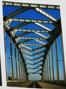
7.29 Verkeersbrug over de Lek bij Wenen (1936). Tussen de bogen een bovenwindverband in K-vorm.
