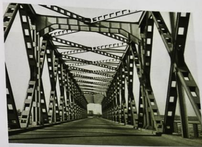
7.30 Verkeersbrug over het Hollands Diep bij Moerdijk (1936, vervagen in 1978). Vakwerkhoofdliggers met een bovenwindverband in rhombenvorm.
